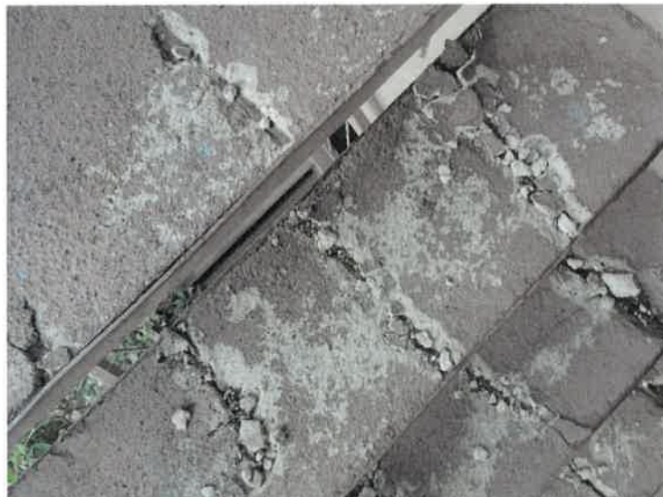
8 階段の損傷
