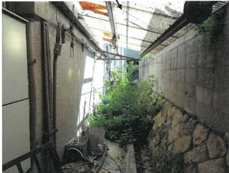
7 工作物（屋根テラス）
