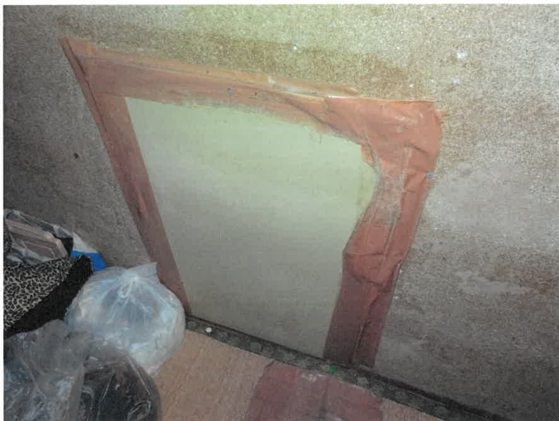
7 壁面の補修跡
