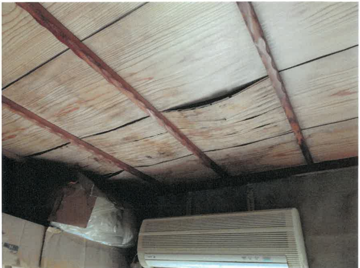
11 天井の雨漏り跡と思われる損傷
