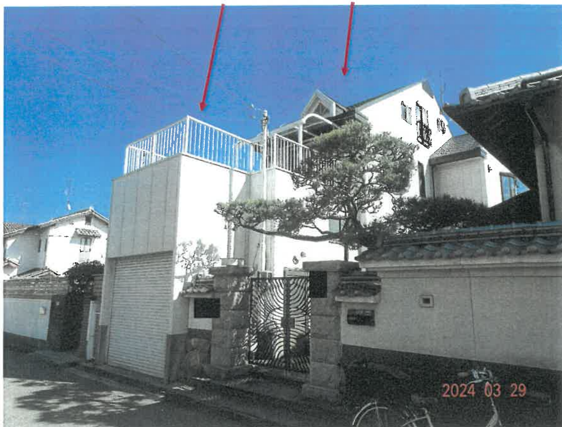
増築部分 ③目的建物
