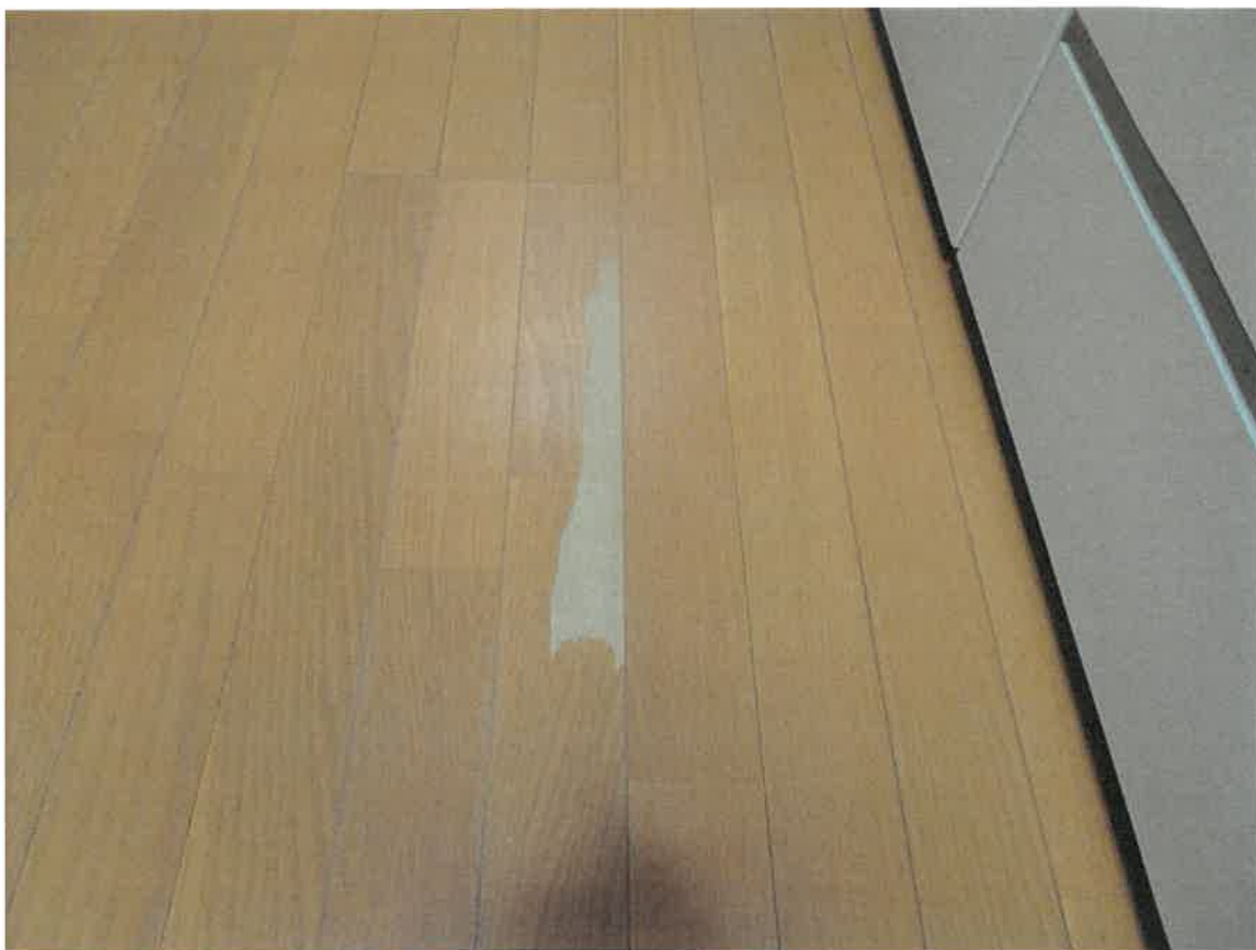
10 床面の損傷
