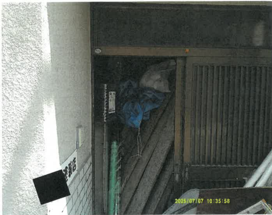
正面玄関の状況（解錠後のもの）
