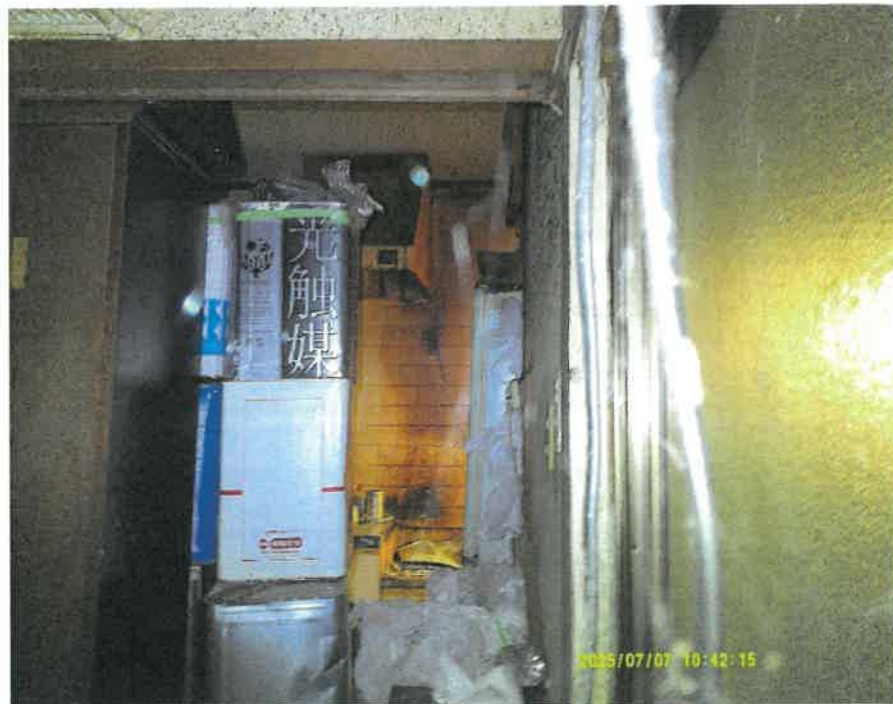
東側小窓から撮影した内部の状況
