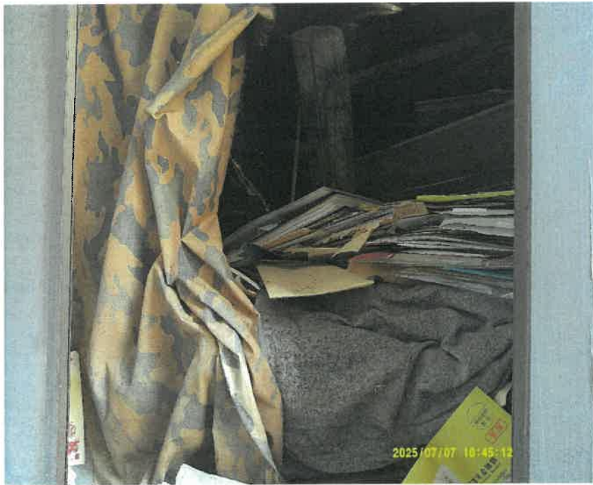
西側窓から撮影した内部の状況
