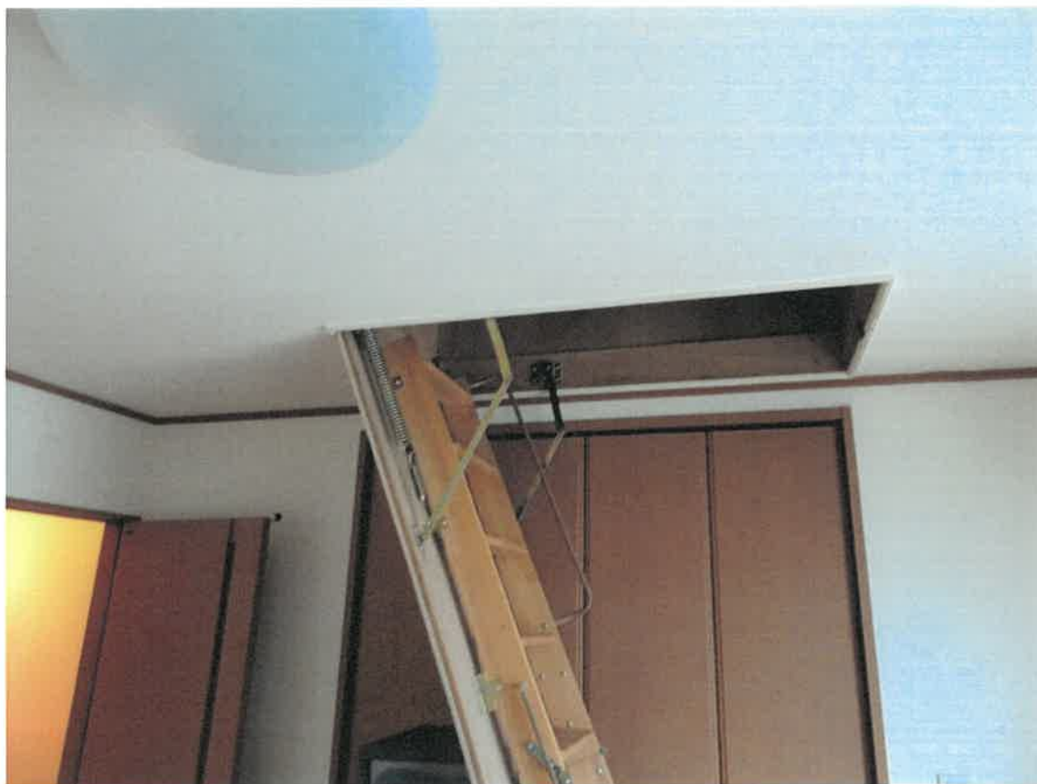
12 屋根裏収納出入口
