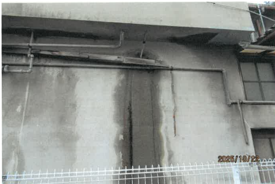
水道管から水が漏れている状況
