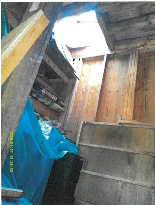
⑤ 1階南西側増築部分の天井の様子
