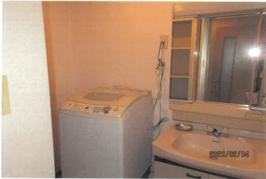
洗面室の状況
