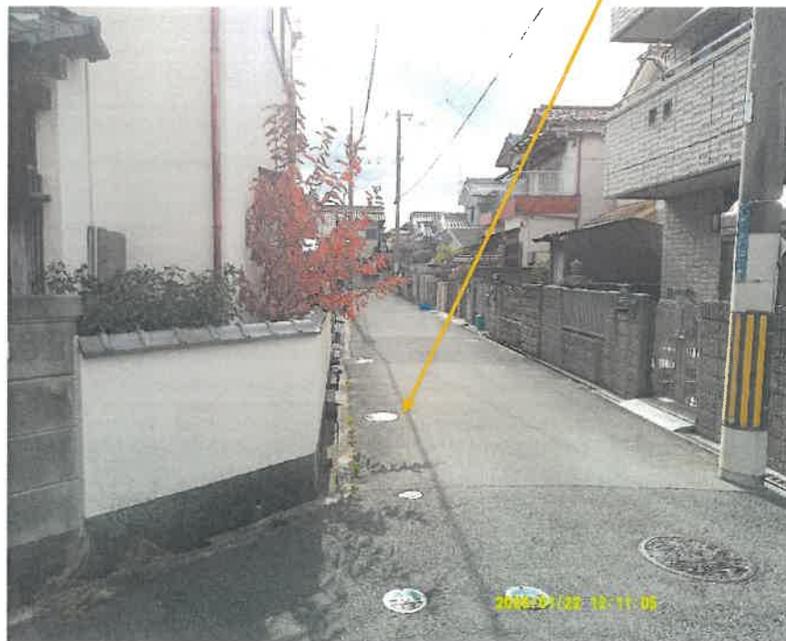
物件1 道路負担部分
