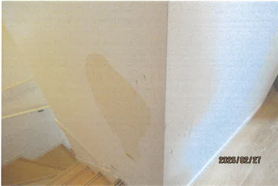
引っ掻き傷・クロスが剥離している状況
