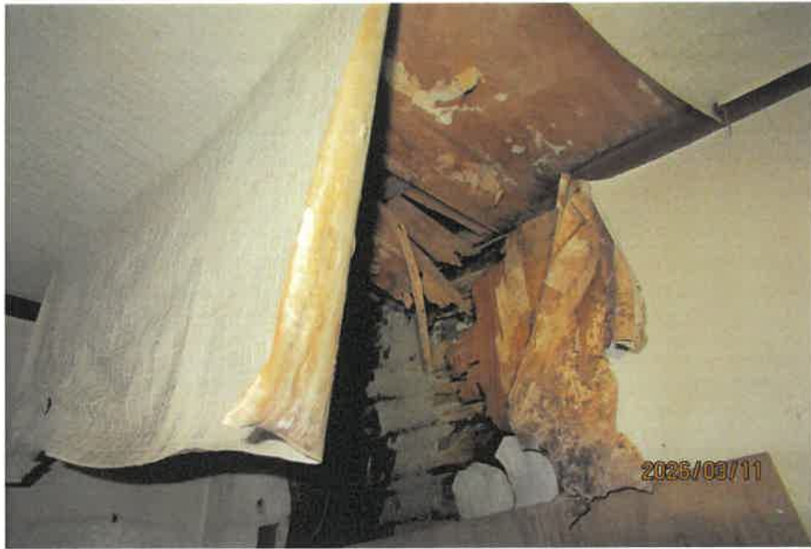
天井等が崩落している状況
