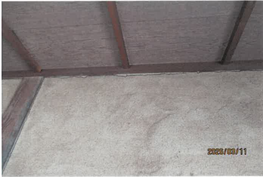
壁にひび割れが入っている状況
