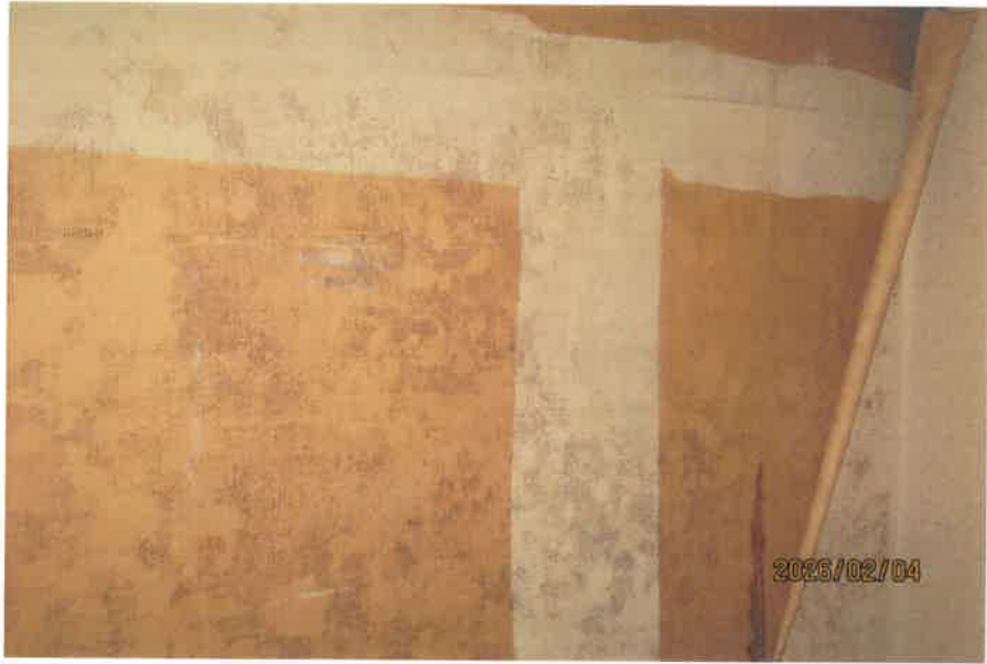
トイレの壁紙が剥離している状況
