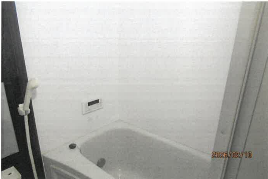
103号室：浴室の状況
