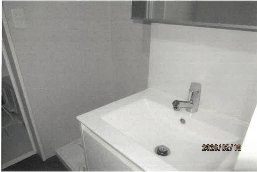
103号室：洗面室の状況
