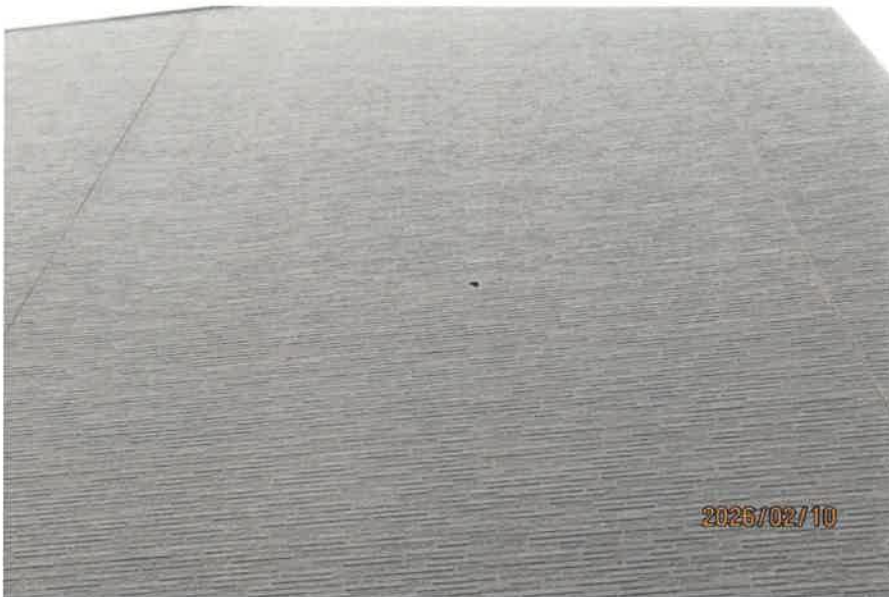
外壁に穴が開いている状況
