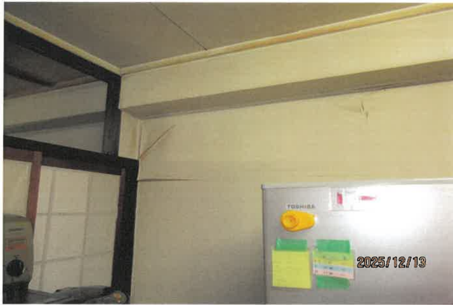
307号室 壁紙クロスが剥離している状況
