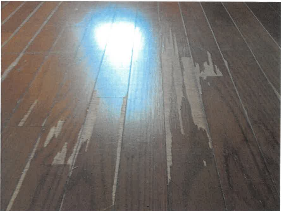
12 床面の損傷
