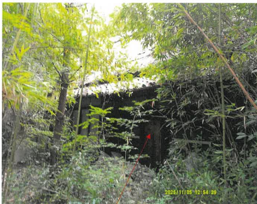
① 物件4（主建物）
