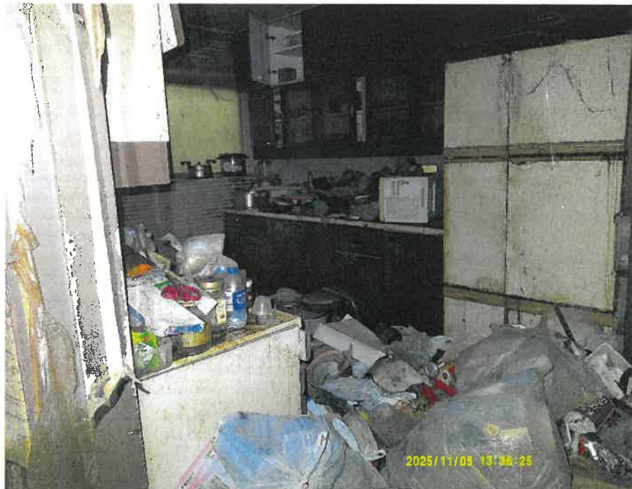
④ 物件 4 (主建物)
