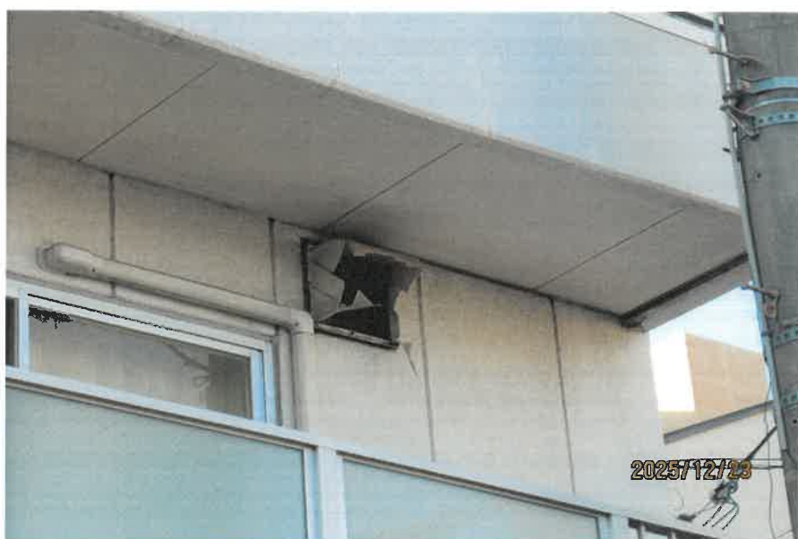
レンジフードが破損している状況
