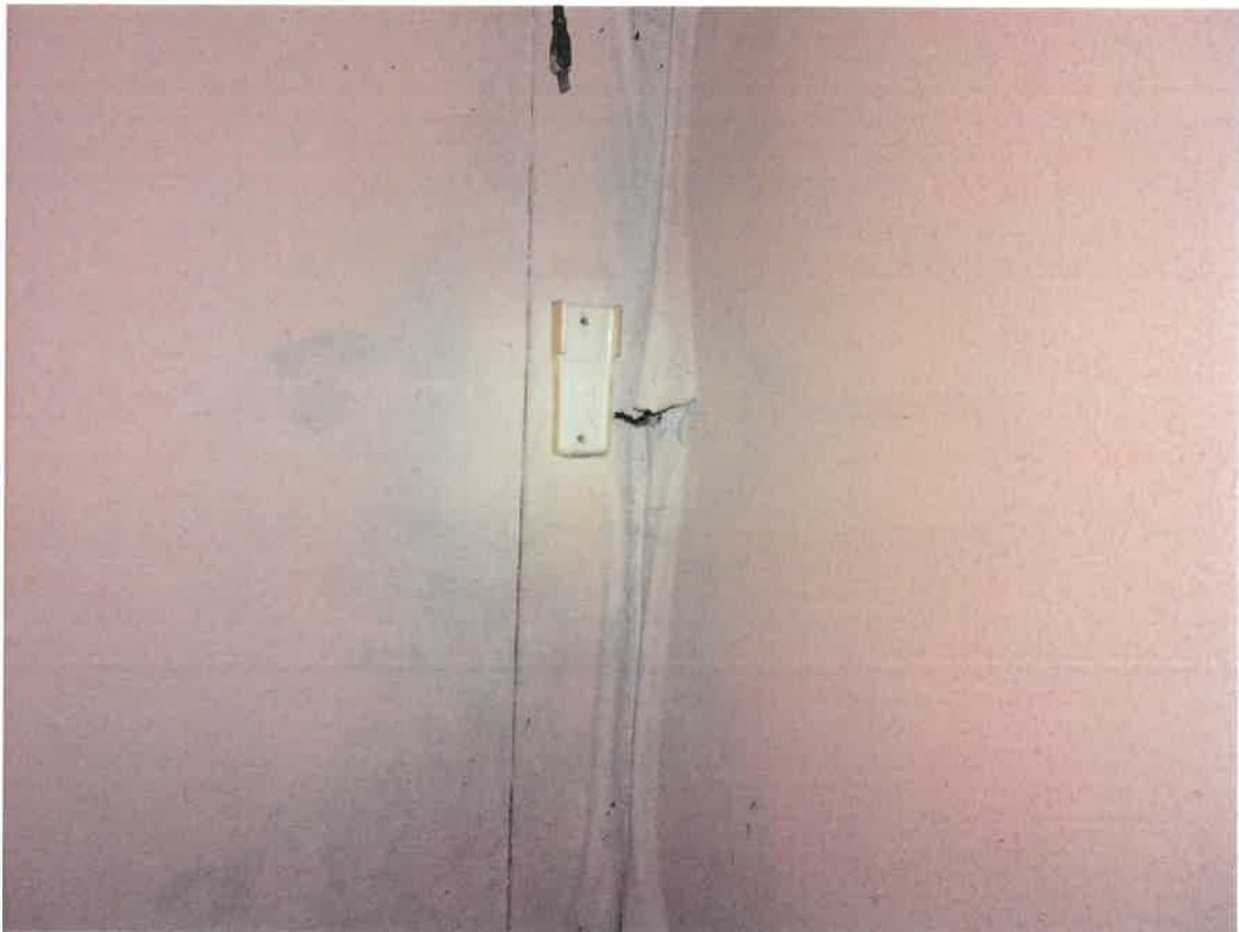
7 内壁クロスの剥離・破れ
