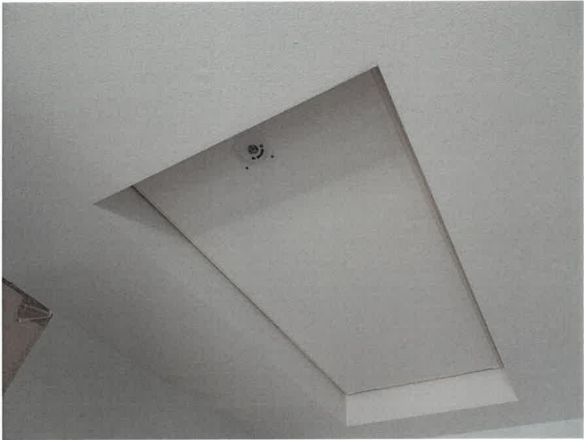
11 屋根裏収納出入口
