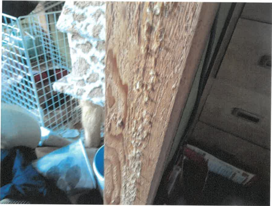
12 柱の損傷
