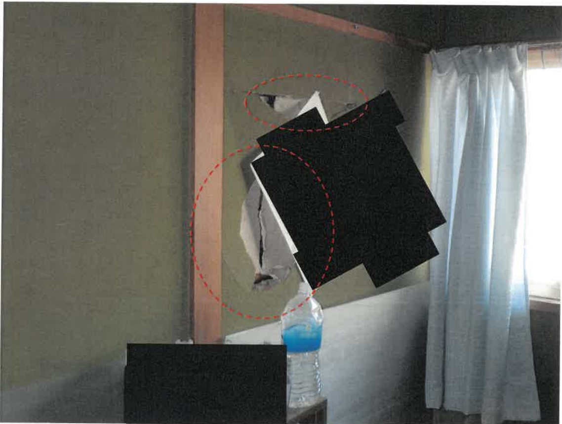
13 壁面の陥没
