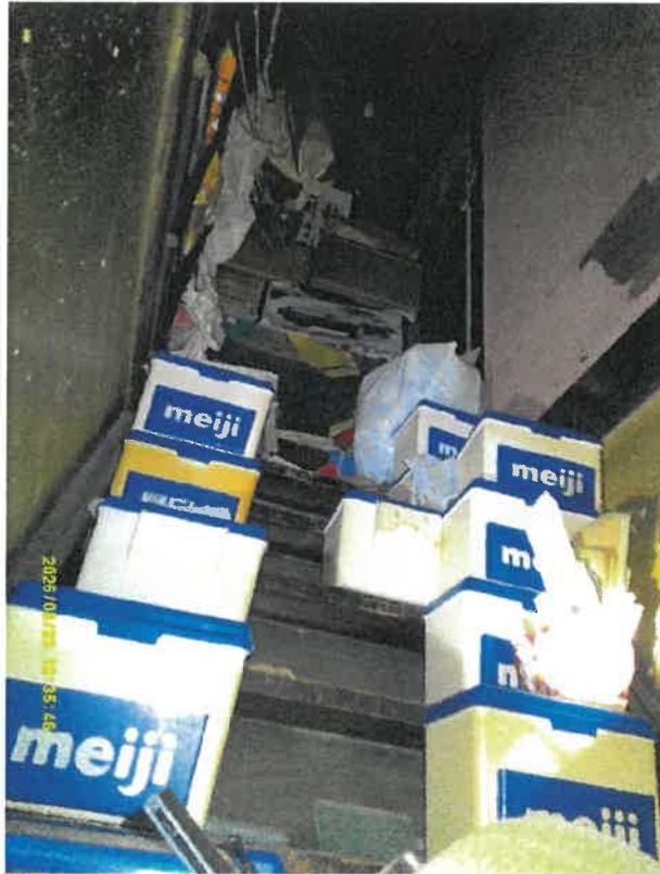
⑦ 階段入口から2階を写した状況
