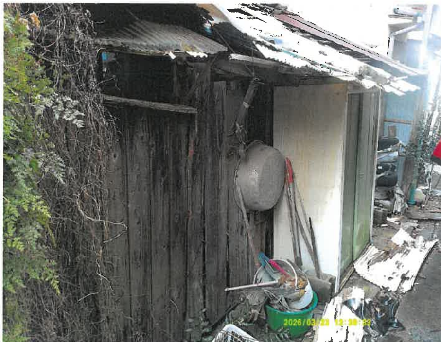
⑩ 建物1階東側増築部分の状況
