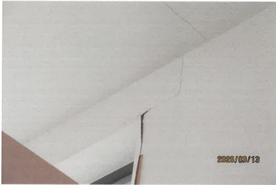
壁紙クロスが剥離している状況
