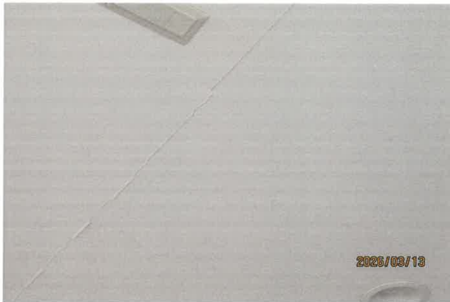
天井にひび割れがある状況
