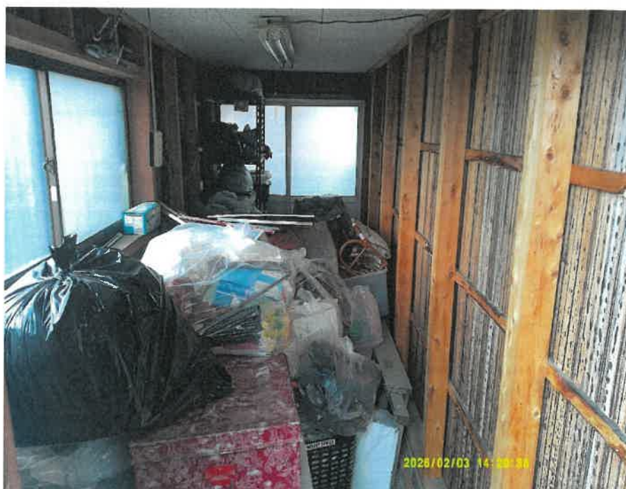
⑫ 未登記附属建物内の状況
