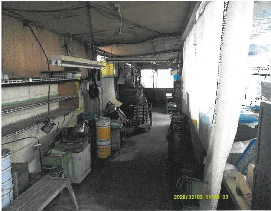
⑤ 1階増築部分の状況
