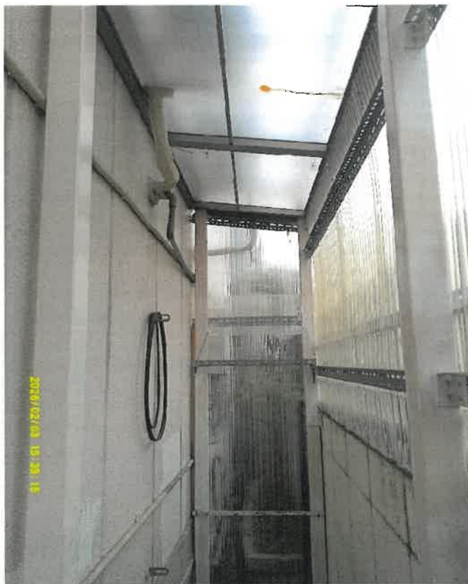
⑥ 1階北東側の工作物（上屋）の状況
