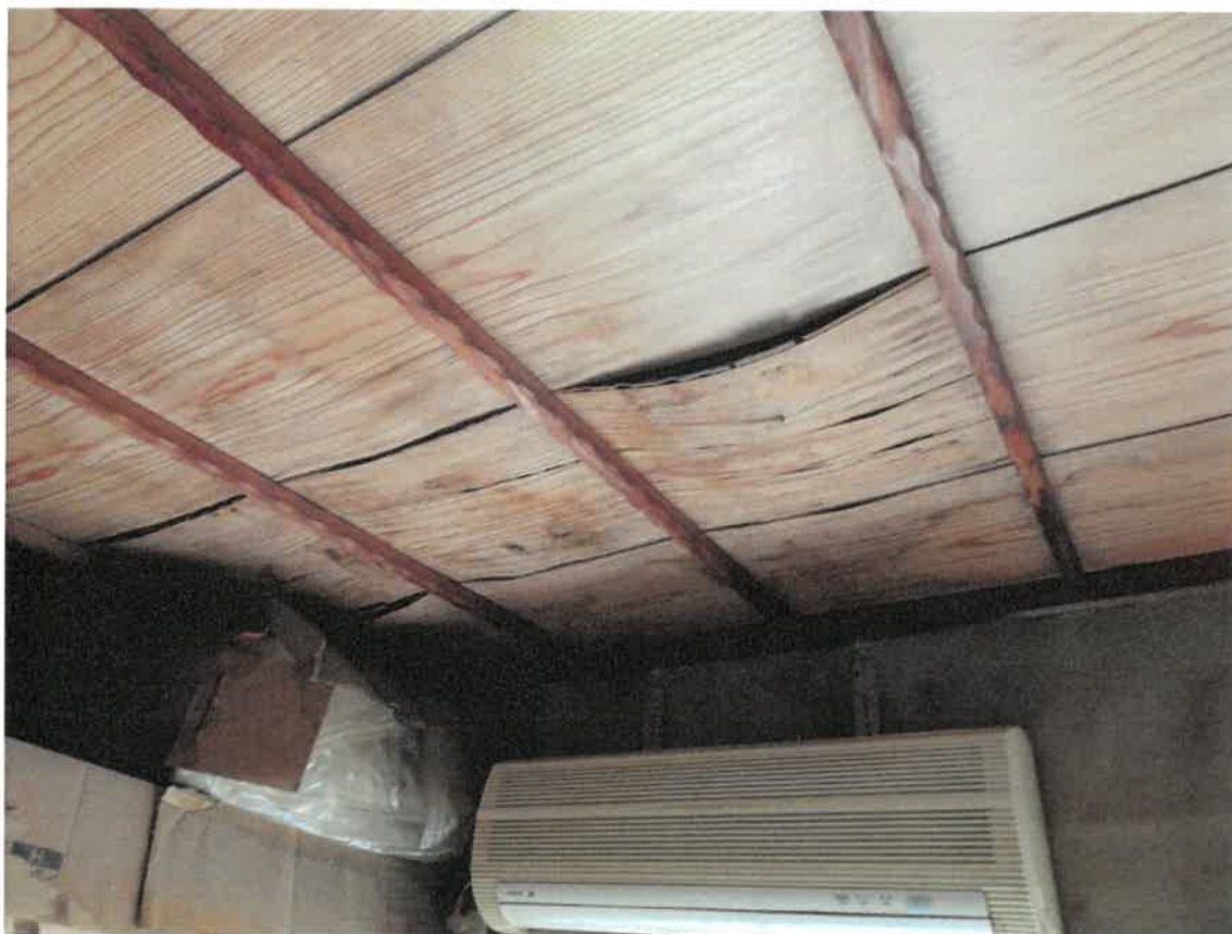
11 天井の雨漏り跡と思われる損傷
