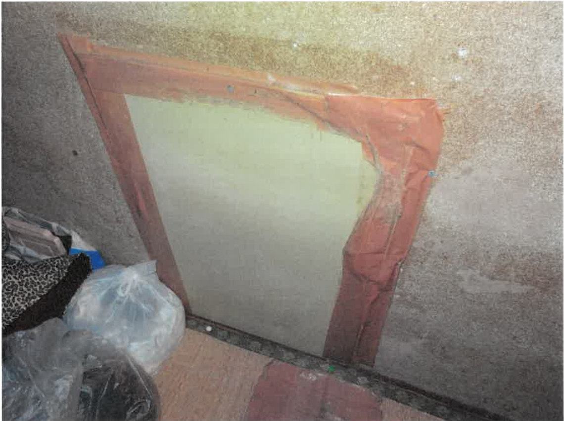
7 壁面の補修跡
