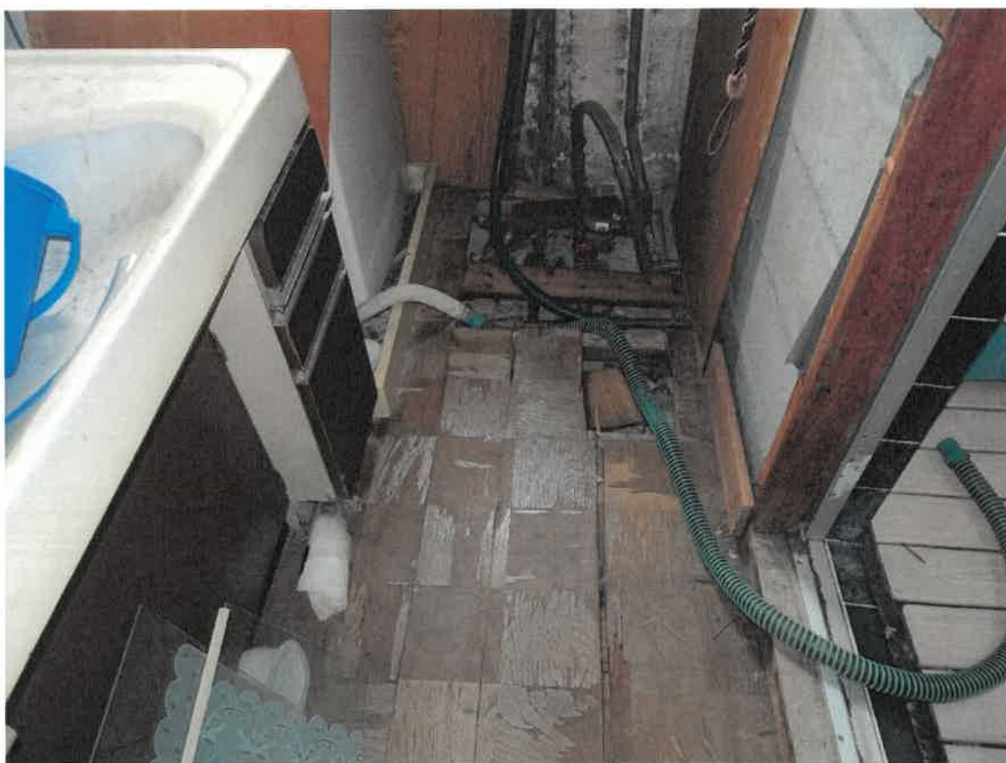
12 床板の損傷
