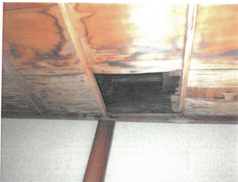
物件 2 天井の雨漏り跡
