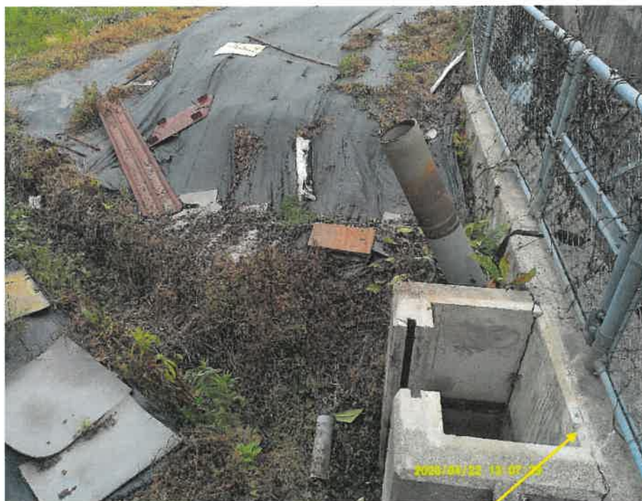
東側水路との境界標
