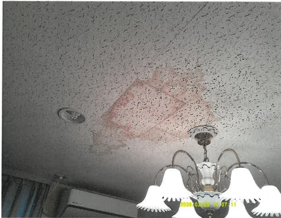
⑮ 応接室の天井の状況
