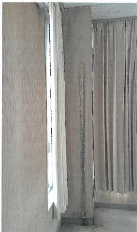
⑯ 会議室の柱の状況
