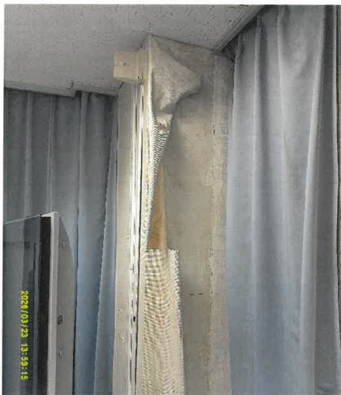
⑪ ホールの南東側柱の状況
