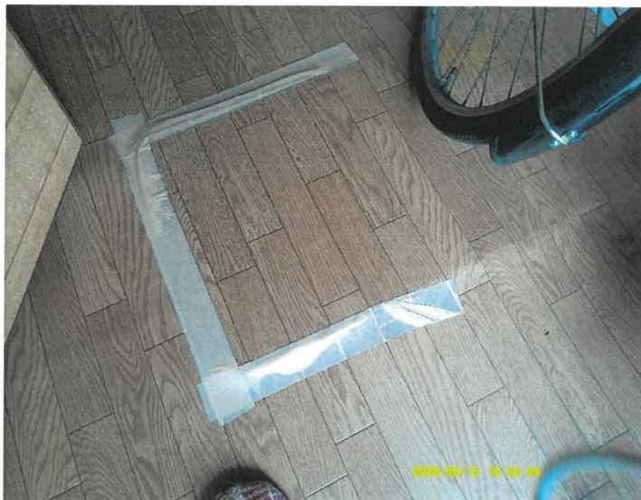
⑪ 玄関ホールの床の状況
