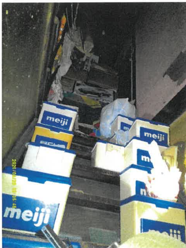
⑦ 階段入口から2階を写した状況
