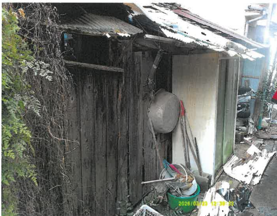
⑩ 建物 1 階東側増築部分の状況
