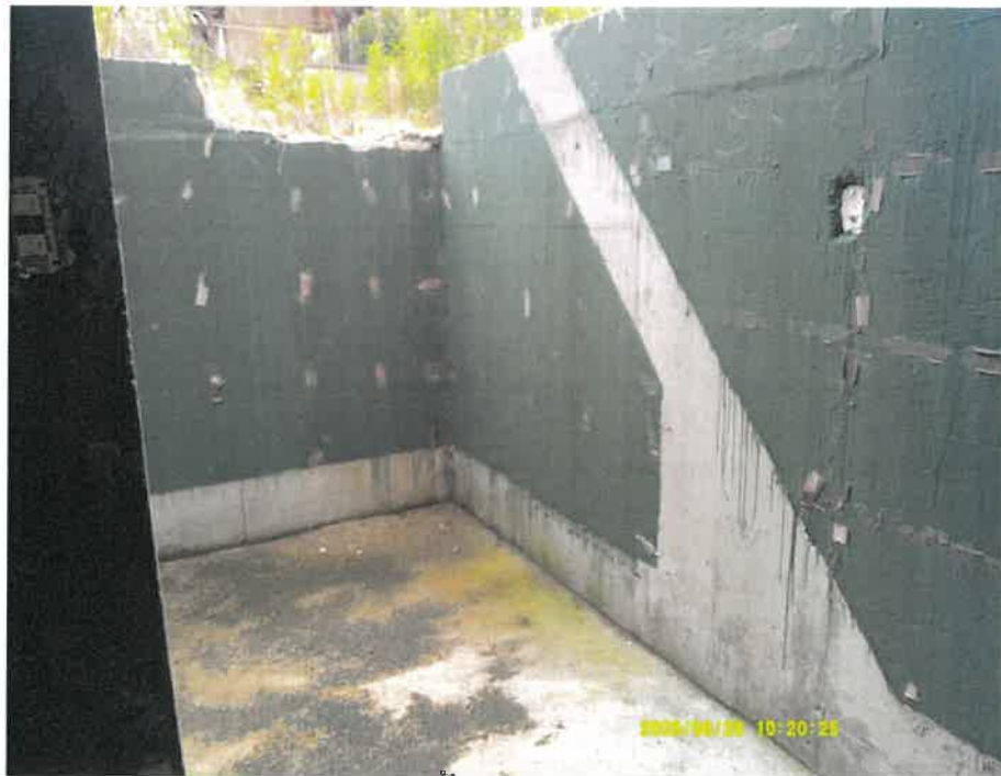
⑦ 建物2階への階段があったと思われる部分
