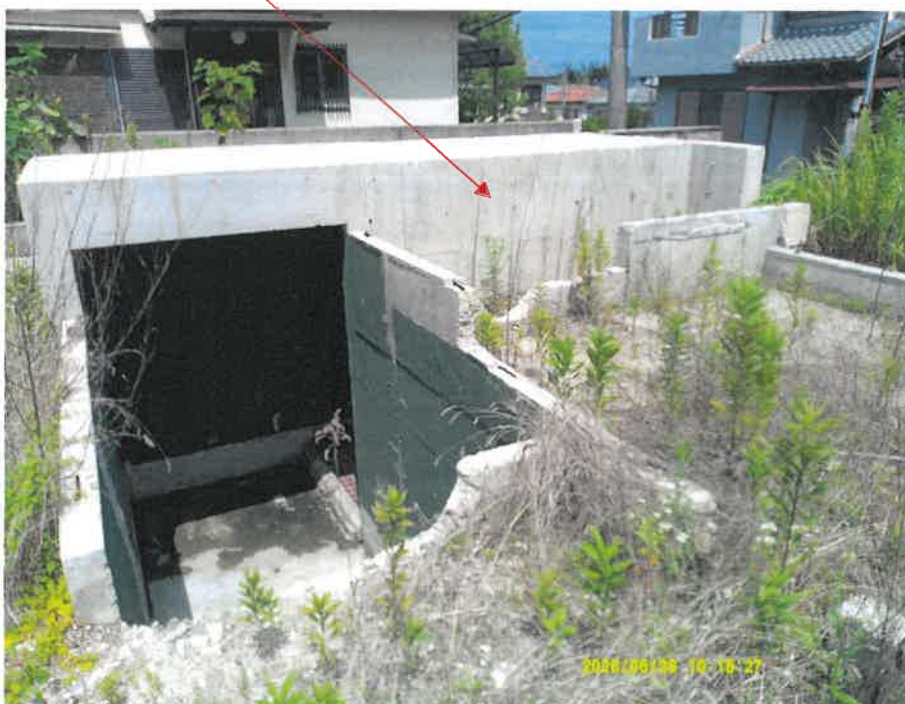
目的建物（1階車庫部分のみ）
