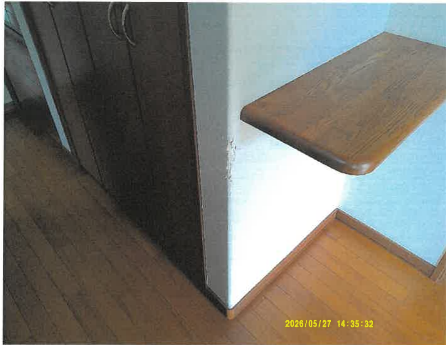
⑪ 内壁クロスのきずの状況（1階）
