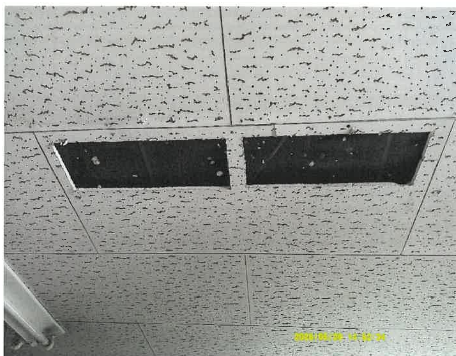
⑯ 3階工場の天井部分の状況
