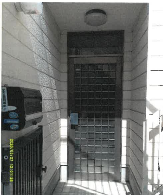
⑩ 1階東側倉庫(出入口)
