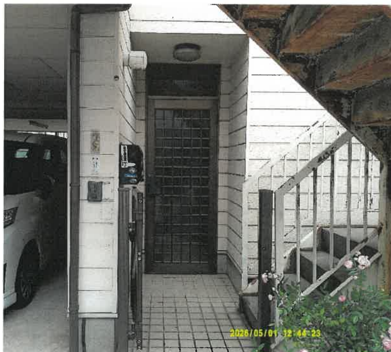
⑩ 1階東側倉庫(出入口)
