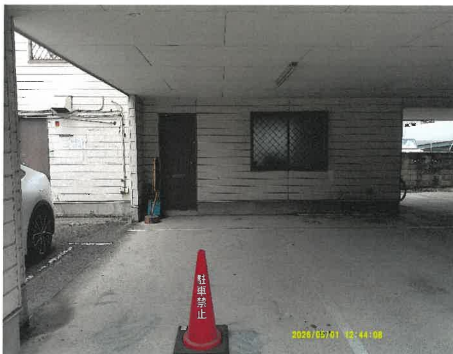
⑦ 1階北西側部分の倉庫(外観)
