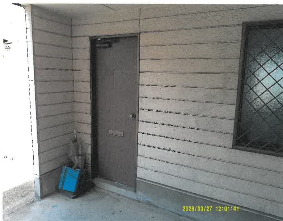
⑦ 1階北西側部分の倉庫(出入口)
