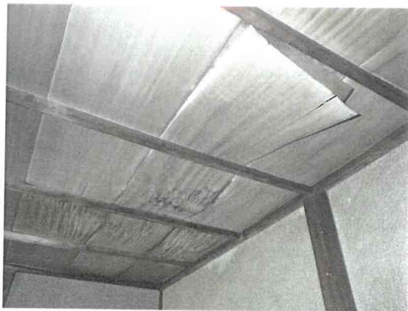
物件 5 天井の損傷
