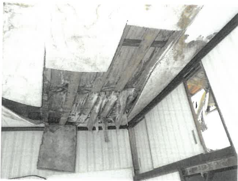
物件 6 天井の損傷
