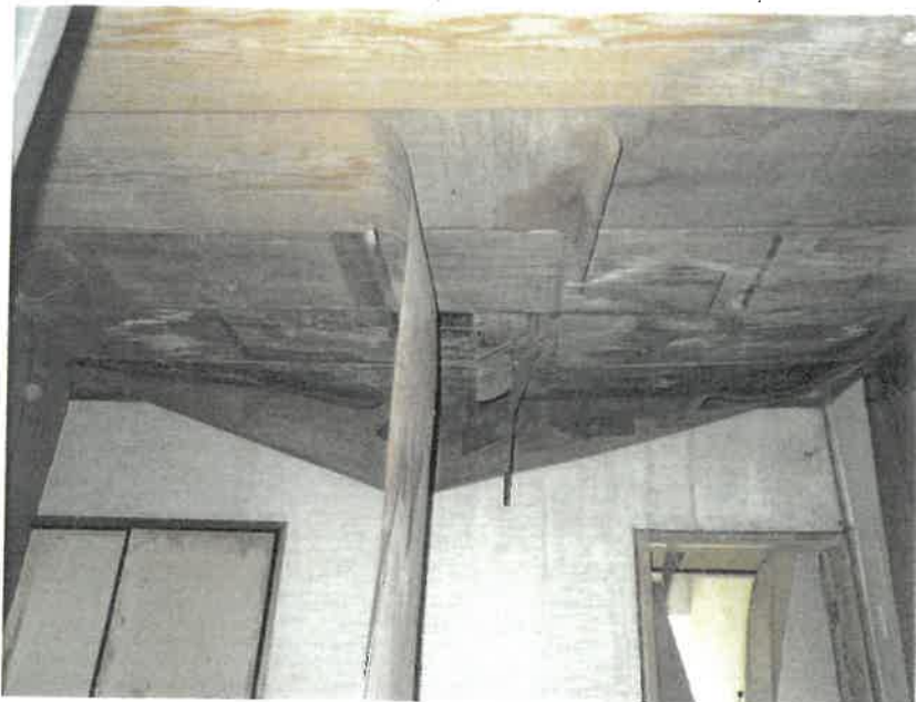
物件 6 天井の損傷
