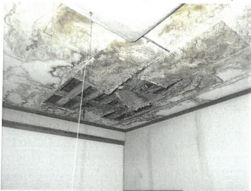
物件 6 天井の損傷
