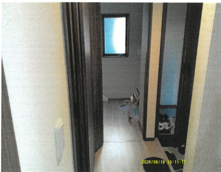
②0 1階玄関ホールの状況
