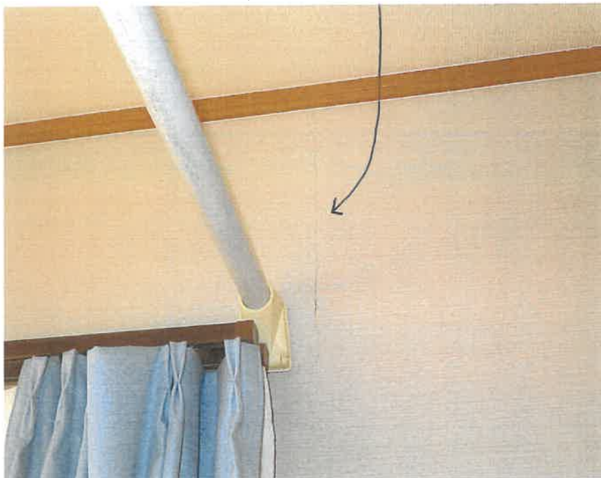
天井付近の壁にある亀裂
