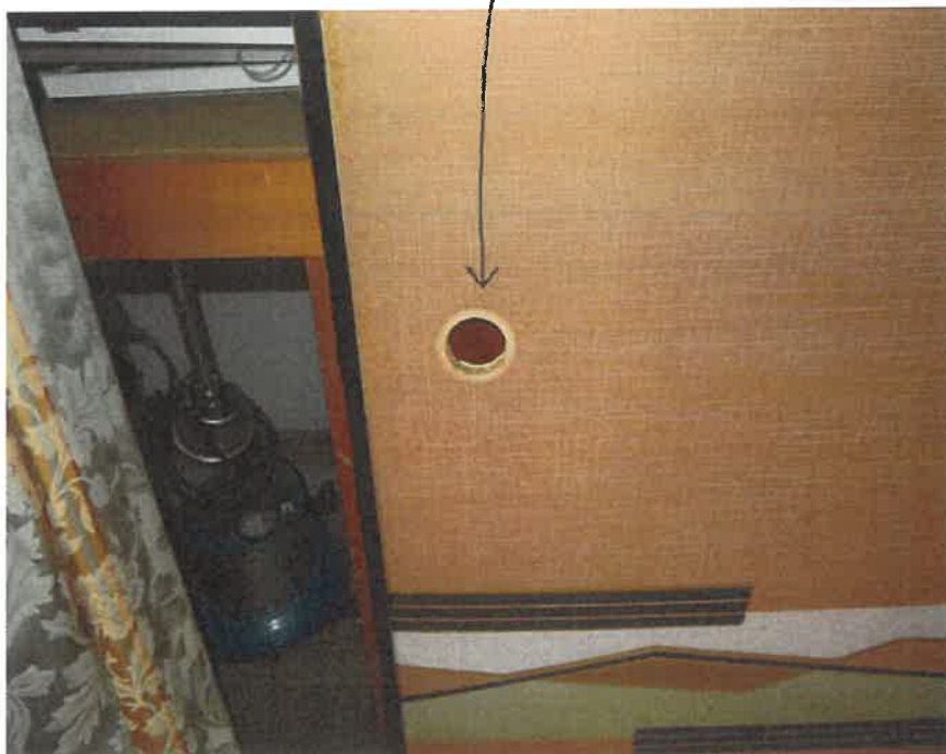
襖の取っ手の欠損
