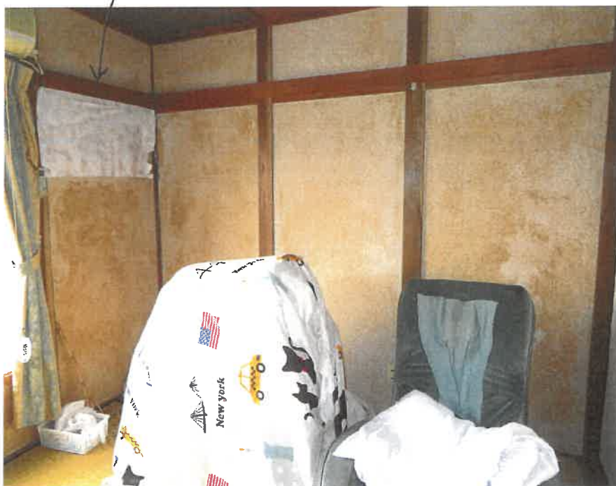
壁の損傷をカバーして貼っている布
