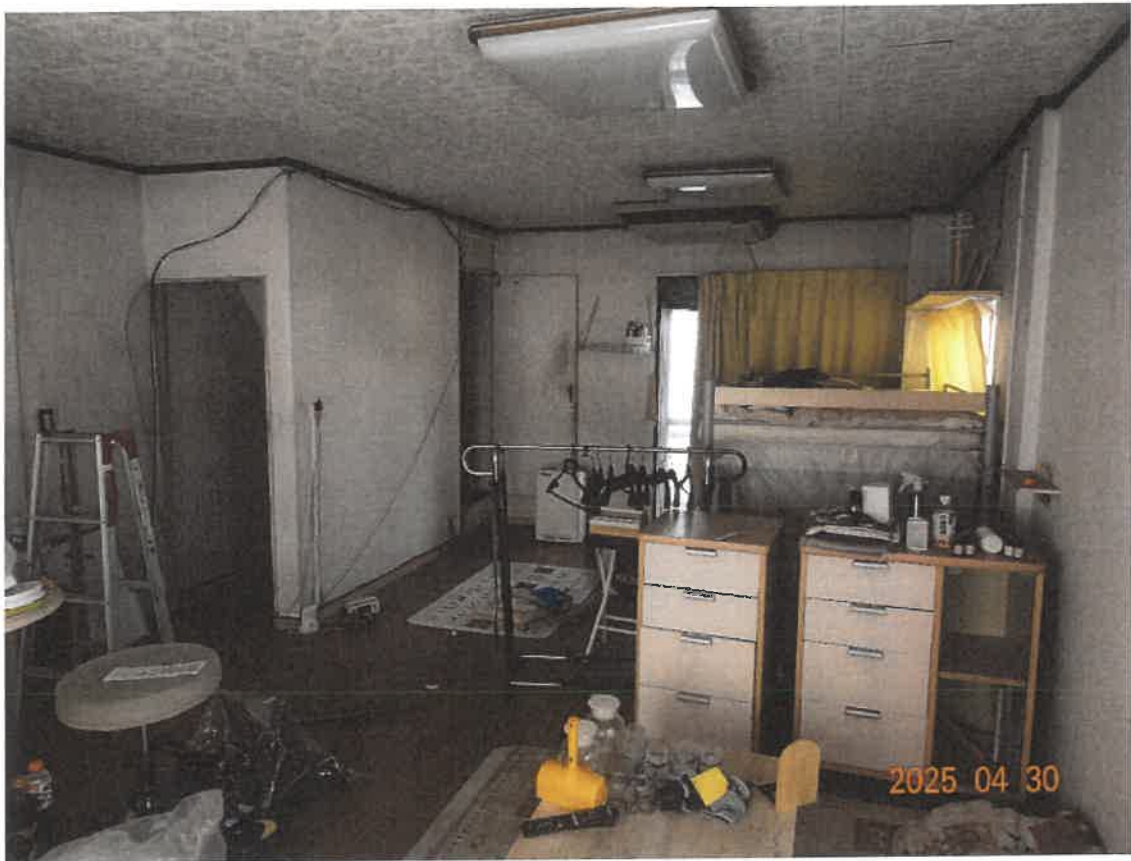
⑥ 2階天井の雨漏りによるものと推測されるしみ
