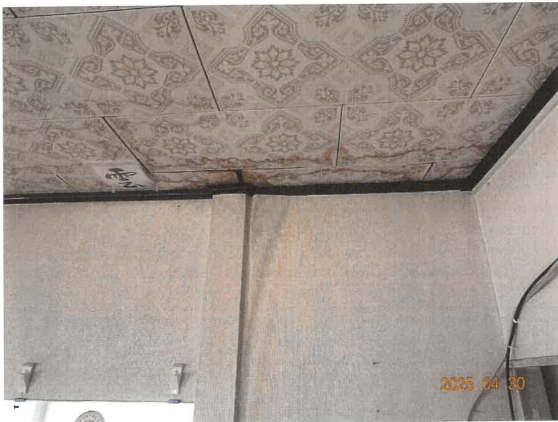
⑥ 2階天井の雨漏りによるものと推測されるしみ
