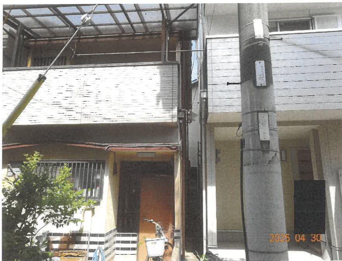
⑬北側隣地上の建物が越境している可能性あり
