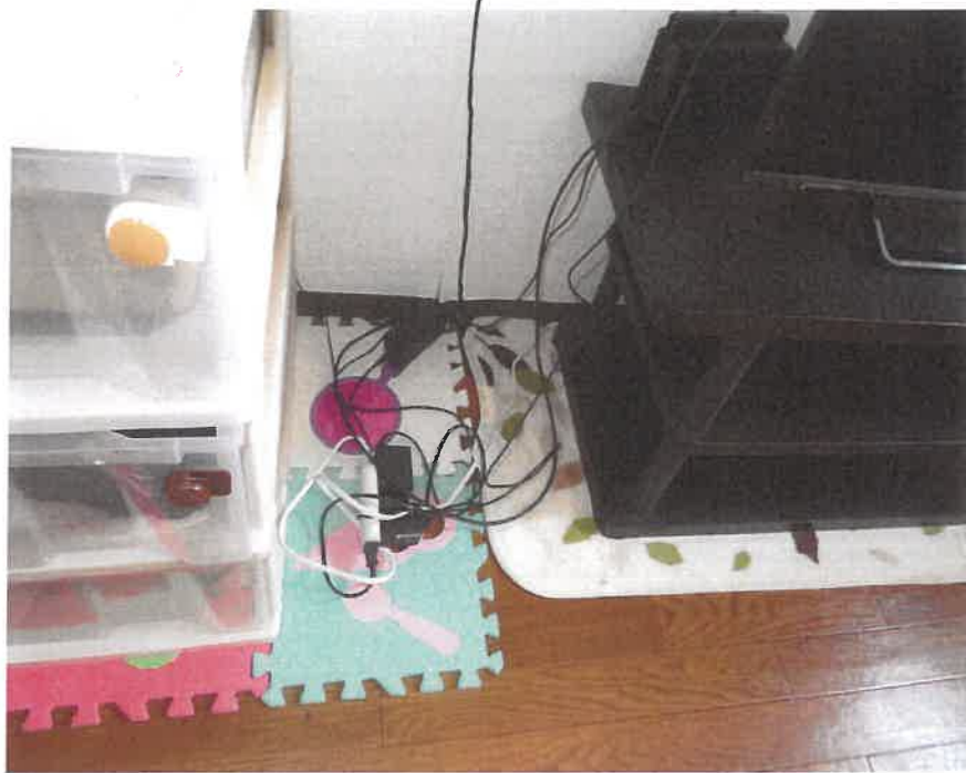
フローリングの下から隆起している所
