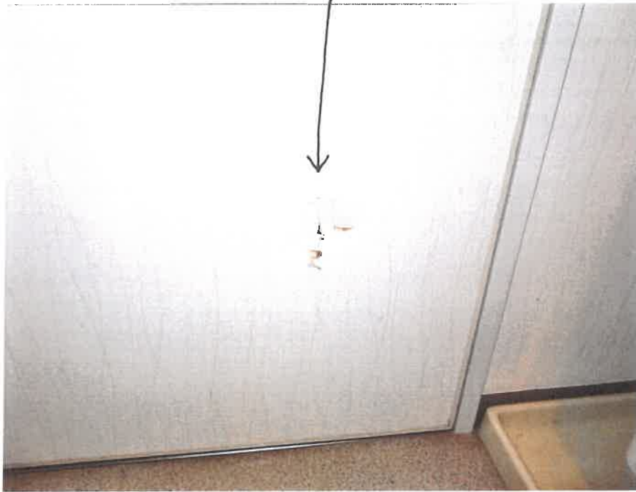
ドアの損傷
