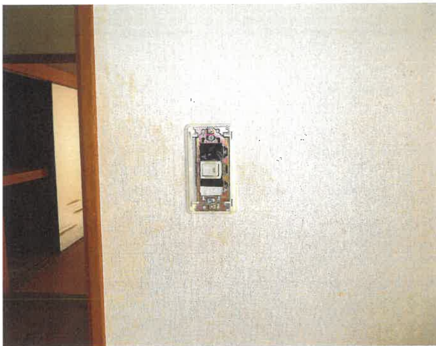
スイッチカバーの欠損
