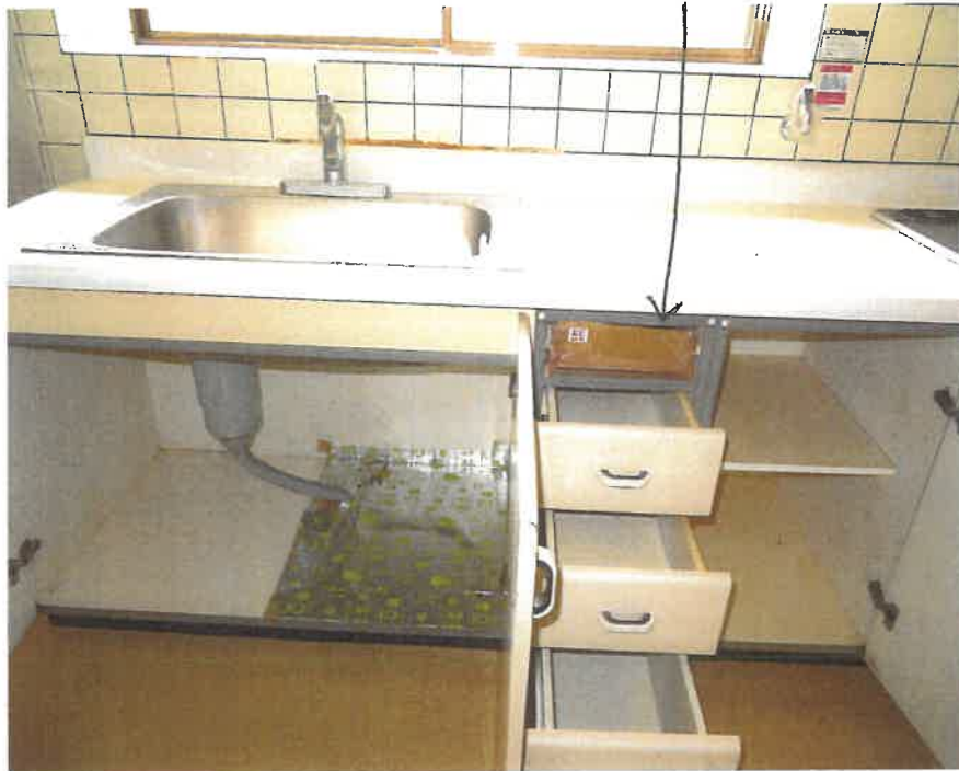
段ボール紙で補修された引出しの前面
