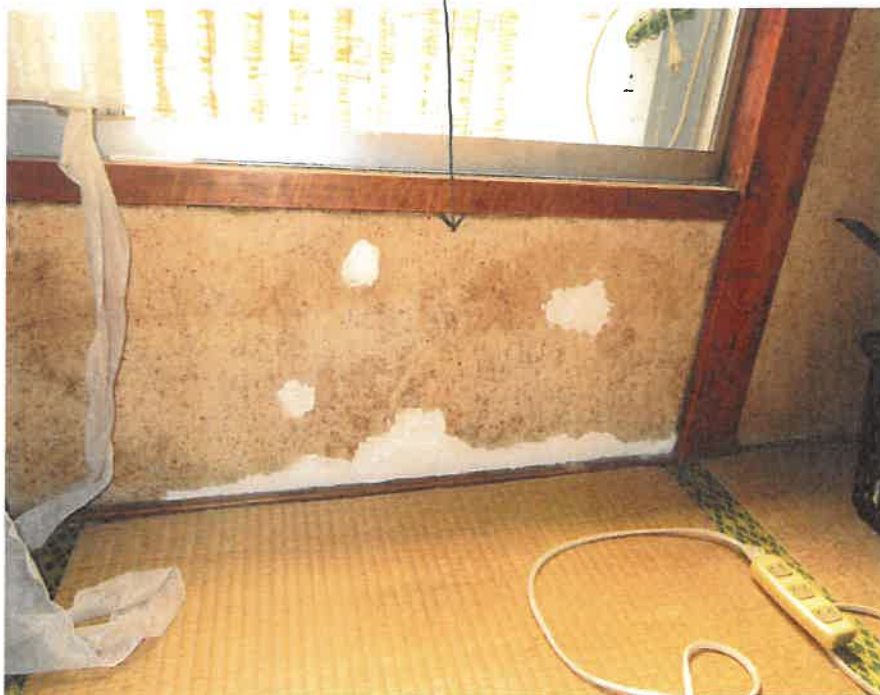
壁の損傷・変色
