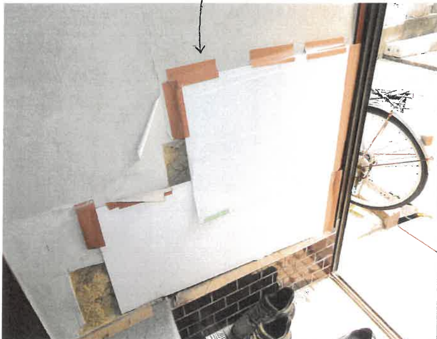
内壁の損傷(陥没)にベニヤ板を貼って補修
