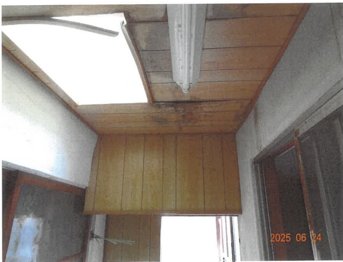
⑫雨漏りによるものと推測される天井の破損部分
