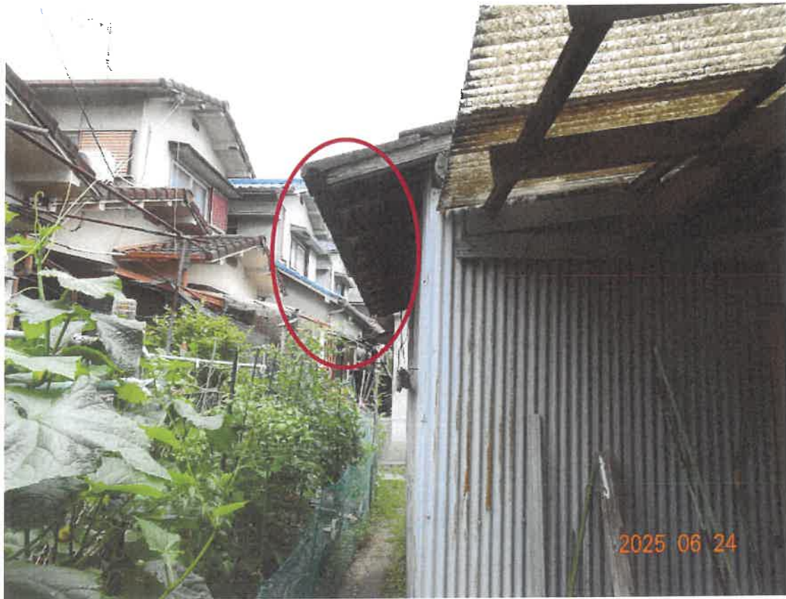
㊦越境の可能性がある屋根
