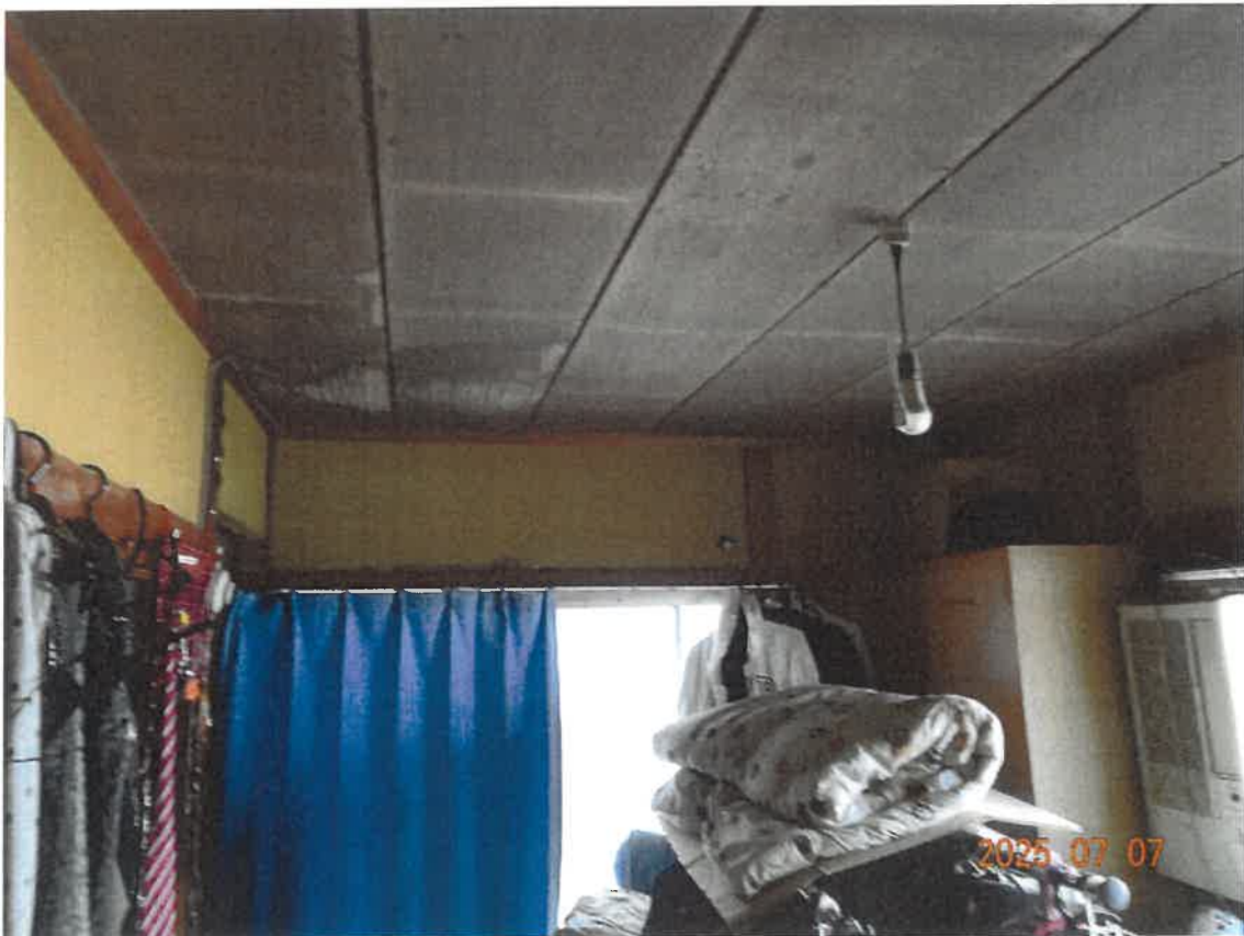
⑭ 2階天井の雨漏りによるものと推測されるしみ
