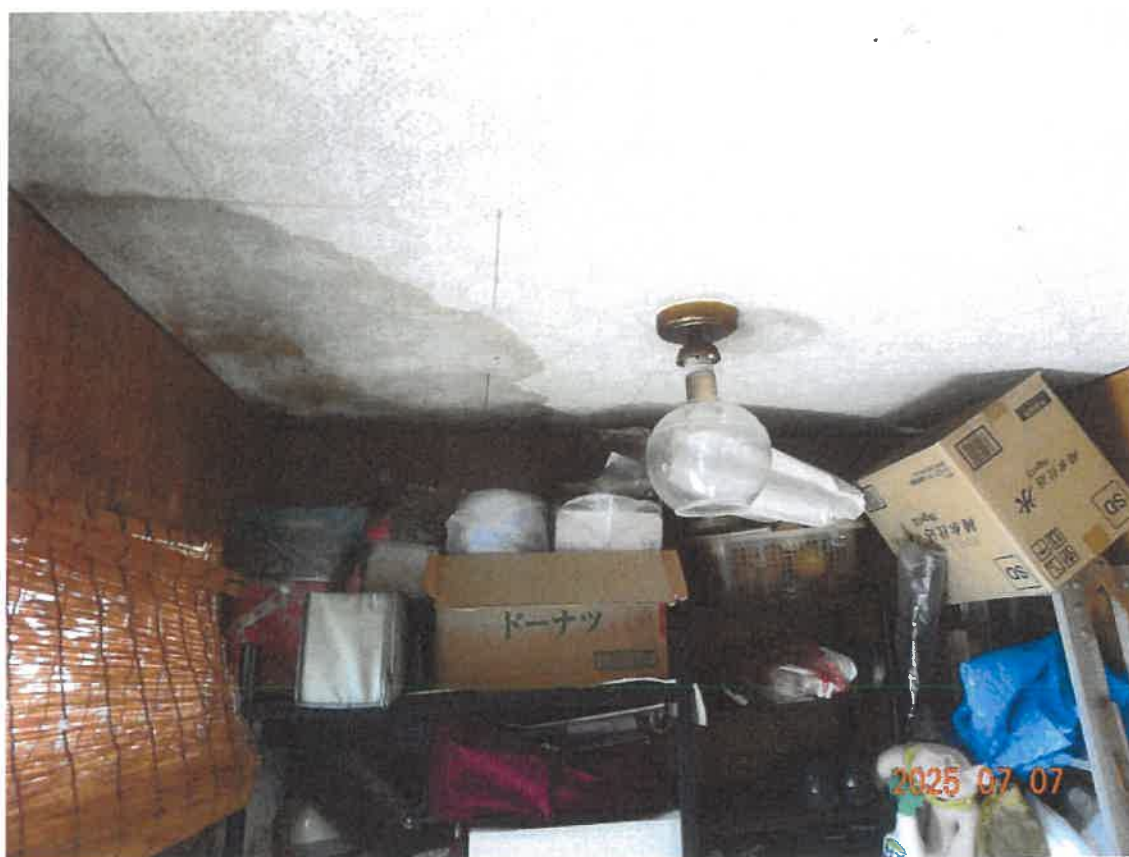
⑮玄関の天井の雨漏りによるものと推測されるしみ
