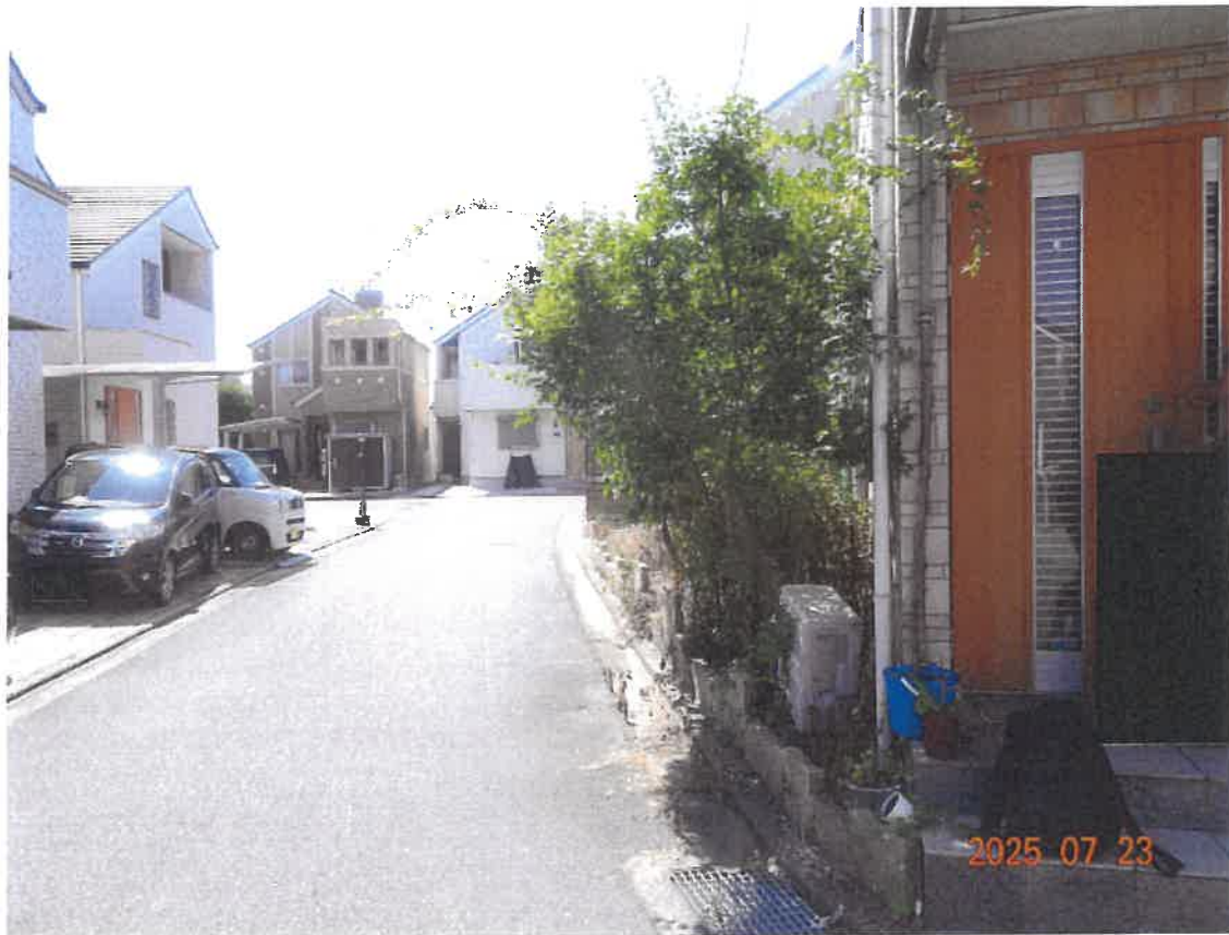
③道路に越境している樹木
