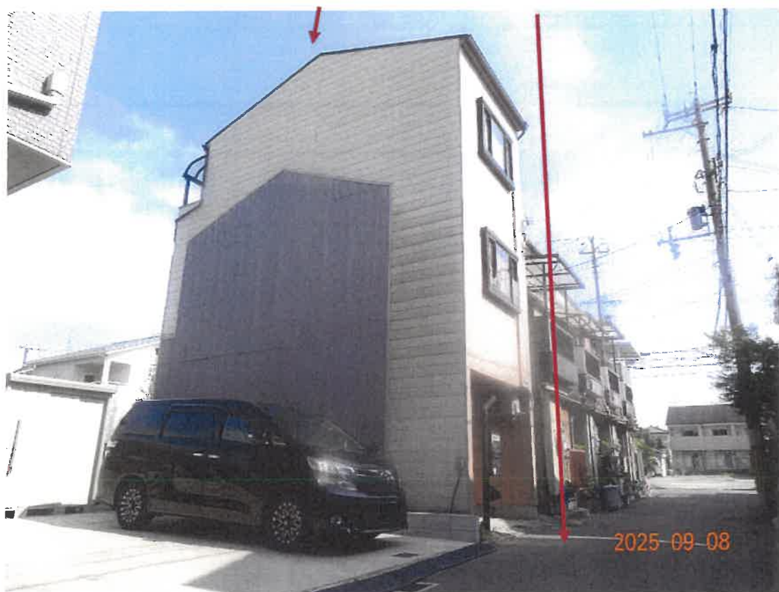
① 目的建物 道路負担部分
